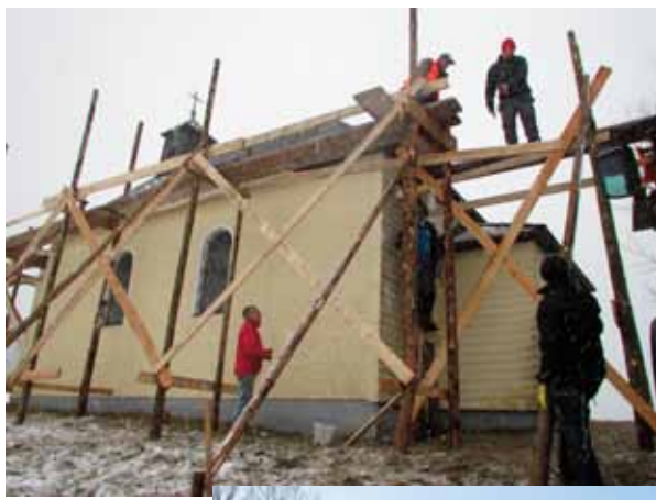
17.03. Das alte Dach wird abgetragen
