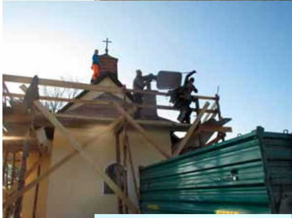
17.03. Das alte Dach wird abgetragen
