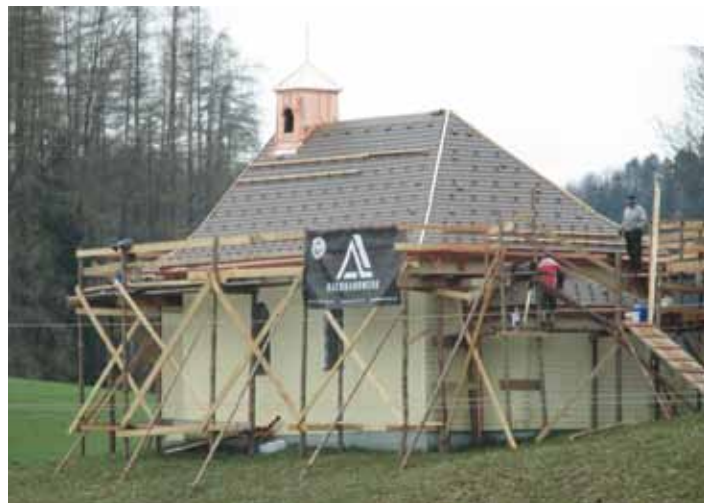
07.04. Jetzt ist das Dach wieder dicht. 25.06. Kreuzweihe und -aufsteckung
